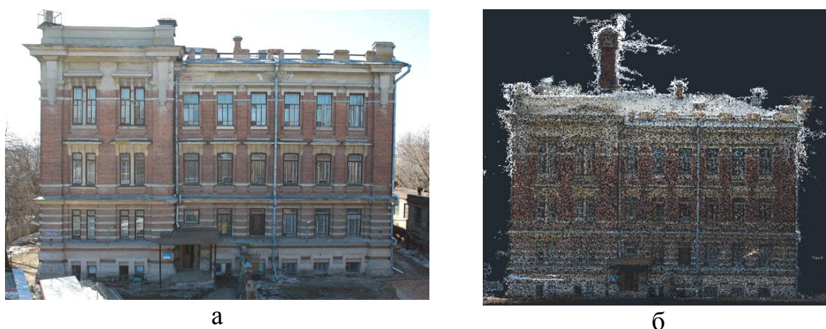
Рис. 2. Фотография объекта (Шамовская больница) и облако точек фасадов здания: а – фотография объекта; б – облако точек фасада здания
